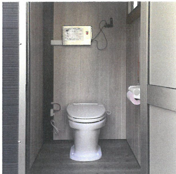
バイオトイレの壁に設置されたIoT機器（黒色の装置）から情報を取得し、管理者が遠隔で利用状況を把握できる仕組みとなっている
