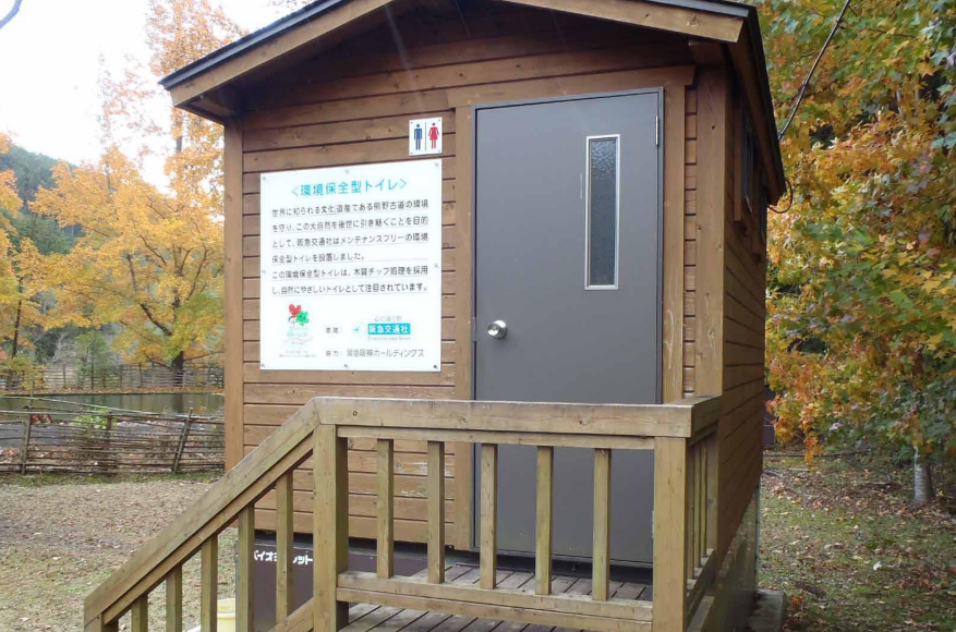
固液分離式を採用したバイオトイレ
